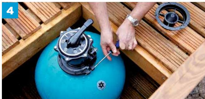
4 Coloque el equipo de filtrado (obligatoriamente ubicado a 3,50 m de la piscina) y, luego, conéctelo mediante los tubos a los skimmers y las boquillas de impulsión.
