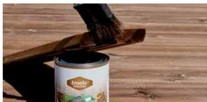
Es necesario volver a tratar todas las piezas de madera recortadas. Este tratamiento complementario solo afectará a las partes situadas sobre el suelo. Las partes enterradas o en contacto con el suelo no deben recortarse ni manipularse jamás.
