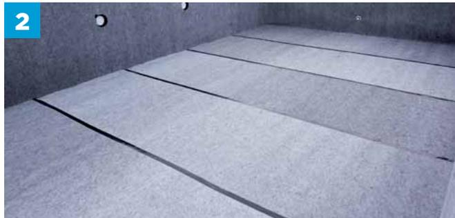
2 Instale fieltros o espumas en las paredes y el fondo de la piscina.
