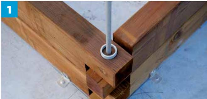
1 Levante las paredes de madera encajando los tabloncillos unos con otros utilizando varillas roscadas.
