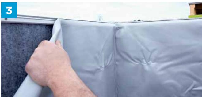
3 Despliegue y coloque el liner en la piscina y luego engánchelo a la barra.
