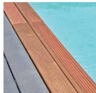
**Coronas de madera de pino clase 4**, alta calidad, perfectamente ajustadas en las esquinas (madera prefabricada tras un tratamiento y un secado), **acabado saturado ámbar**.
