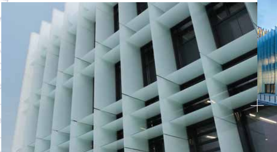
IMREDD - NICE : Profundos Brise-soleil verticales y horizontales
