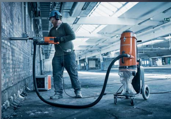
El corte o perforación con colector de polvo integrado captura el polvo directamente en el recipiente. Un extractor clase H equipado con filtro HEPA H13 con el caudal de aire y capacidad apropiada para la aplicación soluciona el problema de polvo. El aire del entorno es filtrado con uno o más purificadores portátiles con filtro HEPA H13 al menos 6 a 10 veces por hora.
