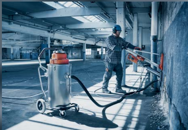
El corte/perforación húmedo/aglomera el polvo con agua directamente en el recipiente. El colector de lodo, conectado a una aspiradora de lodo mantiene limpio el lugar de trabajo.
