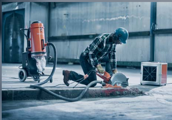
El corte o perforación con colector de polvo integrado captura el polvo directamente en el recipiente. Un extractor clase H equipado con filtro HEPA H13 con el caudal de aire y capacidad apropiada para la aplicación soluciona el problema de polvo. El aire del entorno es filtrado con uno o más purificadores portátiles con filtro HEPA H13 al menos 6 a 10 veces por hora.
