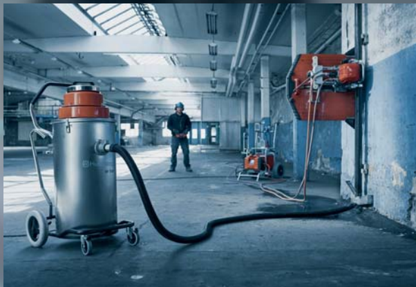
El corte/perforación húmedo/aglomera el polvo con agua directamente en el recipiente. El colector de lodo, conectado a una aspiradora de lodo mantiene limpio el lugar de trabajo.
