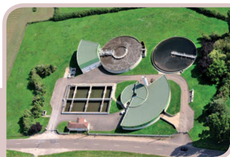
Tratamiento de aguas Water treatment
