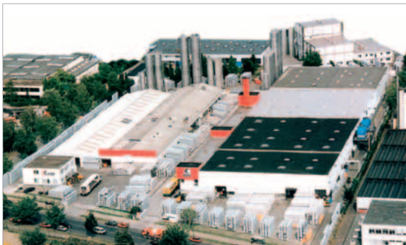
Fabrica de KBE en Berlín. Planta de extrusión, almacenaje y distribución.
