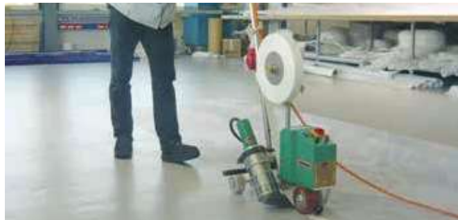
Soldadura de bandas a máxima velocidad.
