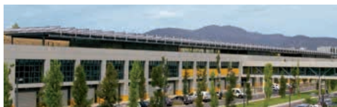
Instalación Hospital Son Espases (Palma de Mallorca). 365 AP-30
