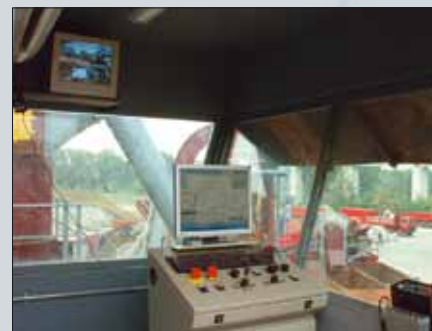
cabina di comando con sistema di gestione
