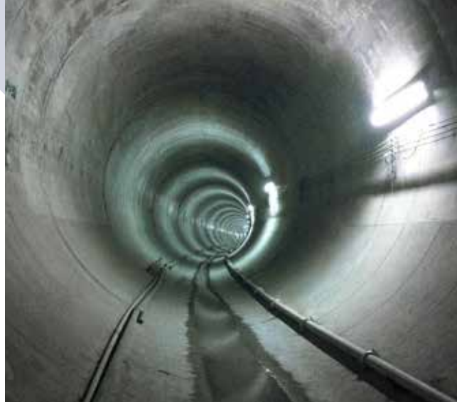
México: Túnel de aguas residuales
