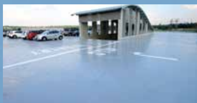
Pavimento exterior (azotea)
