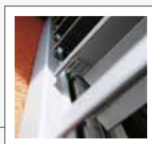
Todas las lamas fijadas en el lateral de manera individual
