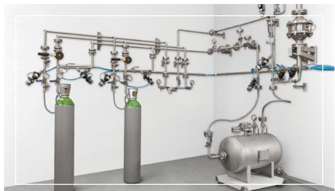
**Módulo evaporador:** Se instala un evaporador SS316L de alta eficiencia, ya sea cerca de la cámara o en la sala de gases, para inyectar ETO en la cámara. Se colocan un apagallamas, así como otros instrumentos en las tuberías del proceso para garantizar la máxima seguridad.
