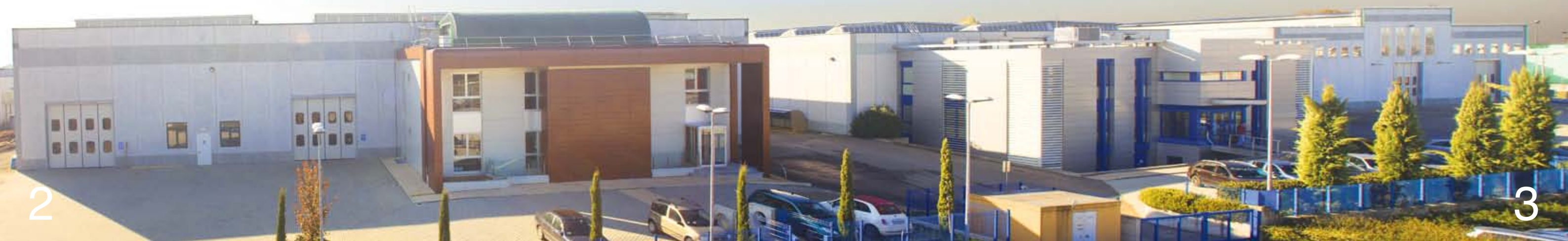
Oficinas Centrales y planta de Gamma Meccanica S.p.A.
