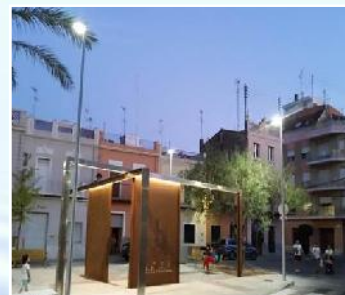
FABRICACIÓN E INSTALACIÓN LUMINARIA LED AYTO. ALGEMESÍ
