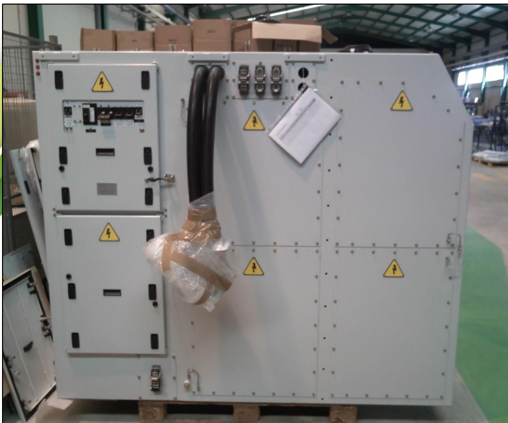
Fabricación de Armario eléctrico de potencia
