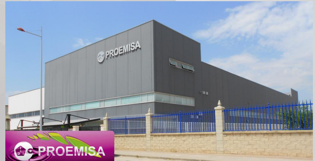
Nave de PROEMISA ubicada en Algemesí (Valencia)
