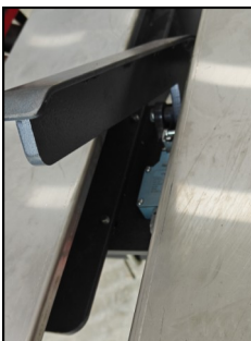
Sensor final de carga. Activa luz en cabina
