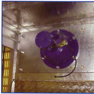
Freno paracaídas de emergencia Overspeed emergency brake
