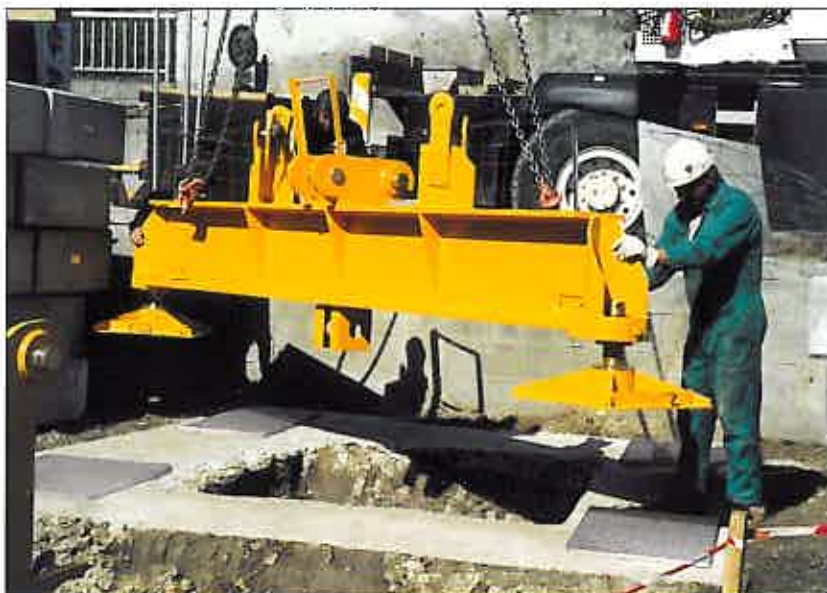
Preparación del suelo y montaje del brazo principal
