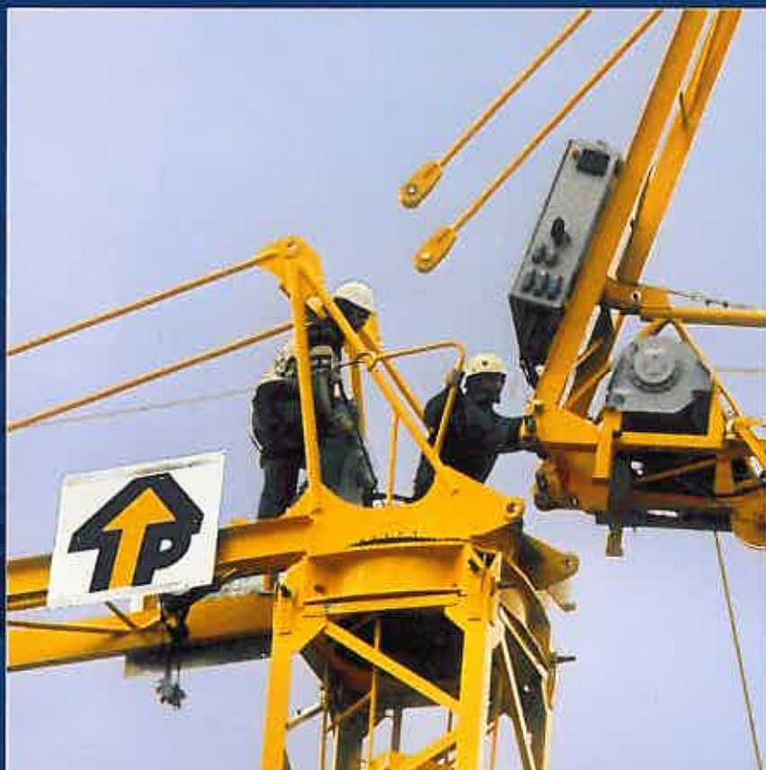
Acercamiento y conexión de la flecha y del puntal delantero
