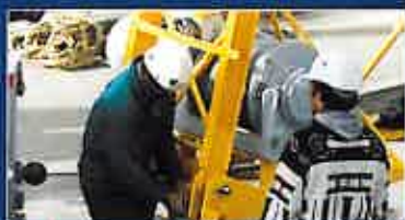
Colocación de los bulones
