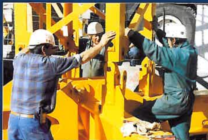
Llegada y montaje
