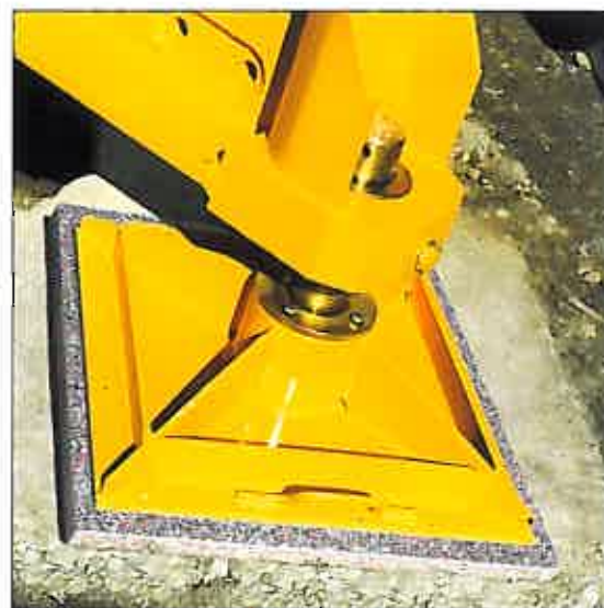
Colocación sobre la base de apoyo y puesta al nivel
