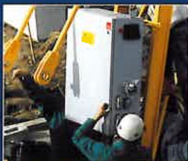
Colocación del armario eléctrico
