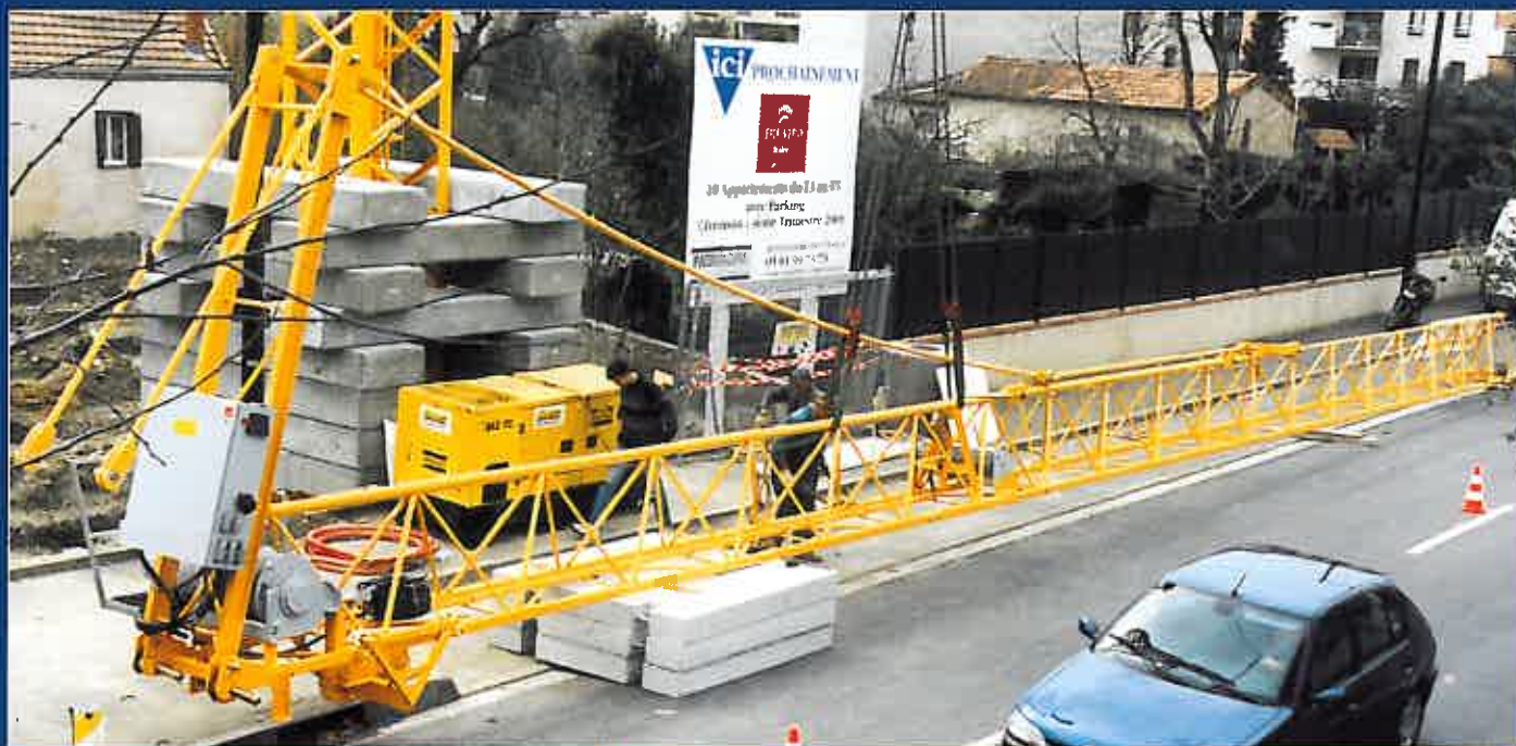
Colocación del tirante de la flecha y del puntal delantero
