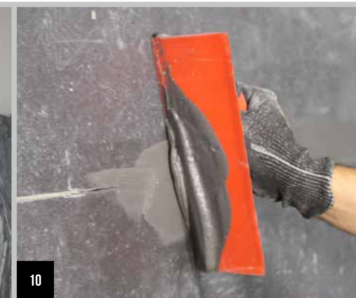
REJUNTADO DE LAS PIEZAS Y LIMPIEZA FINAL
