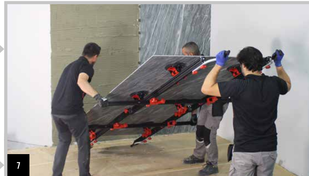
COLOCACIÓN DE LA CERÁMICA
