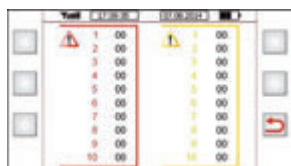
ESTADO DE LAS ALARMAS Y DE LAS CONDICIONES DE BLOQUEO DE LA GRÚA.
