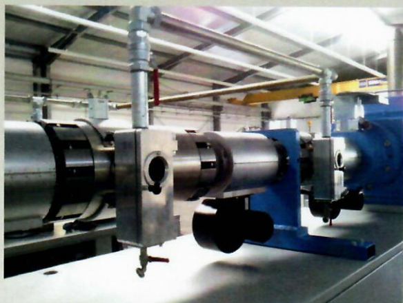
estación de limpieza por vacío
