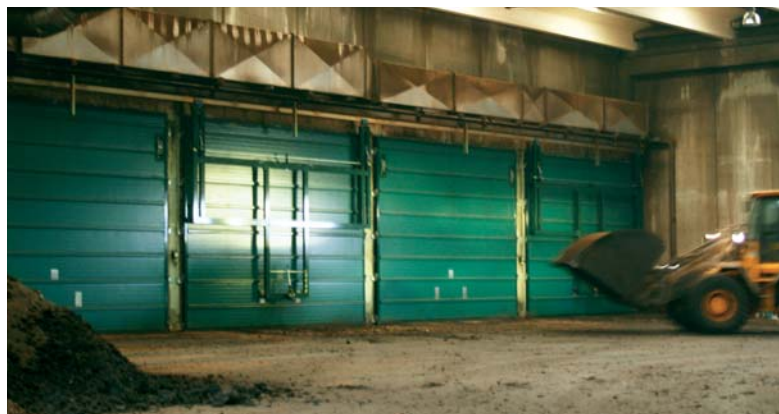
Después de la instalación
