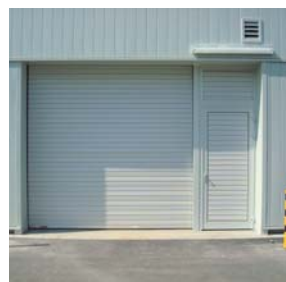
Puerta de paso lateral.
