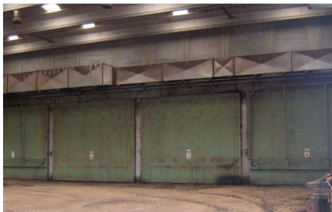
Antes de la instalación
