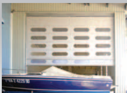
Puerta rápida en cabina.
