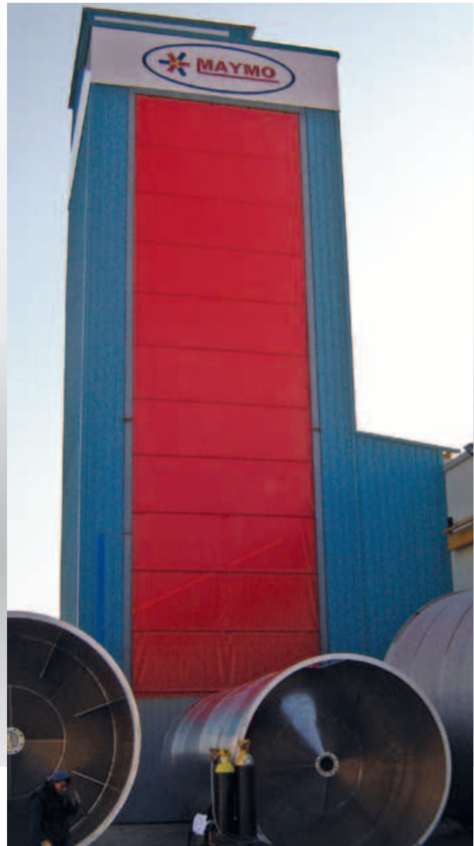
Grand-Pass® en empresa de fabricación de silos/depósitos.
