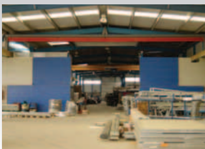
Puerta rápida puente grúa.
