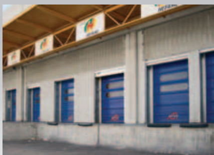
Puertas rápidas en muelles de carga.
