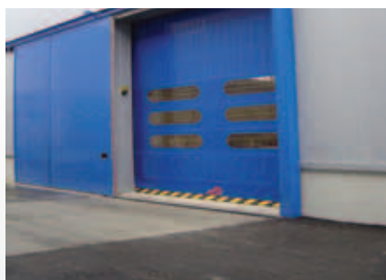
Puerta rápida combinada con puerta cortafuegos.
