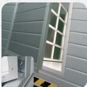
Puerta de paso con zócalo reforzado amarillo y negro. Detalle micro-seguridad.
