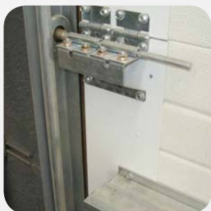
Bisagra lateral doble reforzada 3"
