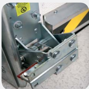
5. Paracaídas por rotura de cable.
