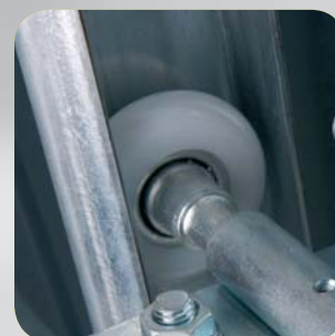
10. Detalle rodillos de nylon y guía.
