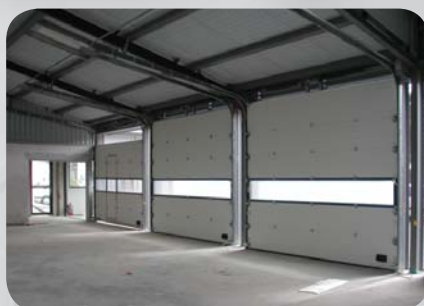
Vista interior puerta seccional Alu-Mix® 1CA con policarbonato celular 16 mm. sin travesaños intermedios.
