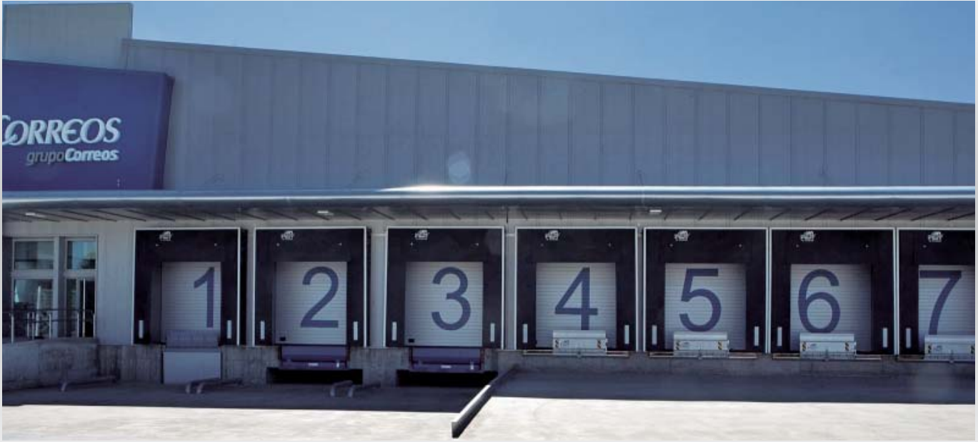
Rampas HIDRA y pasarelas
