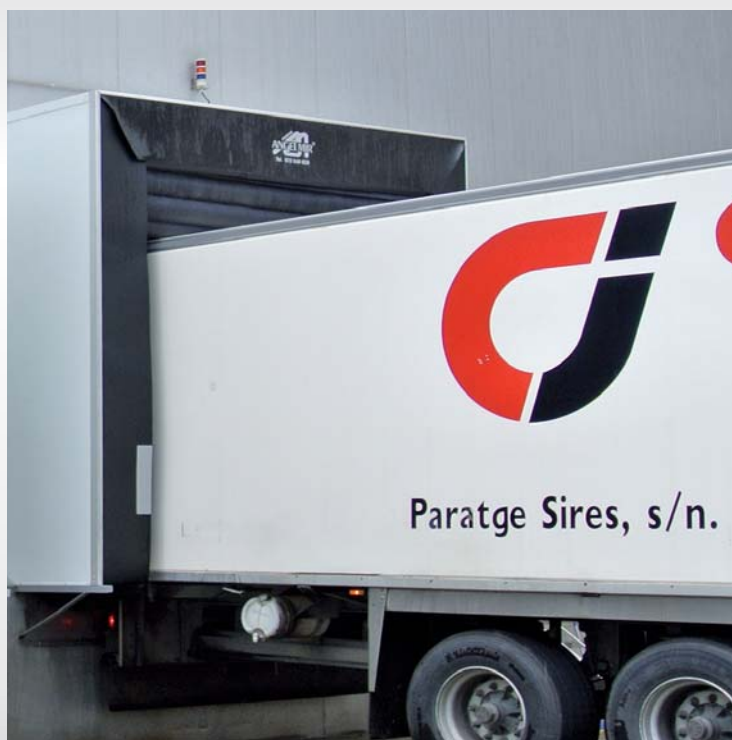
Detalle de estanqueidad en partes inferiores
