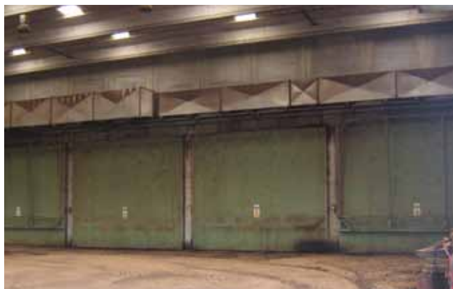
Antes de la instalación
