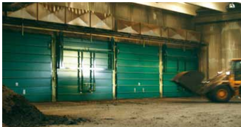
Después de la instalación
