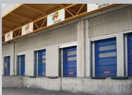
Puertas rápidas en muelles de carga.
