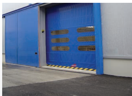
Puerta rápida combinada con puerta cortafuegos.
