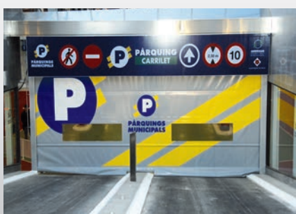
Puerta rápida acceso parking.
