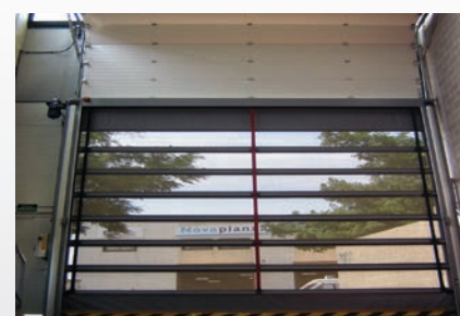
Puerta rápida con lona perforada vista interior. Para control de entrada de personas, animales,...
