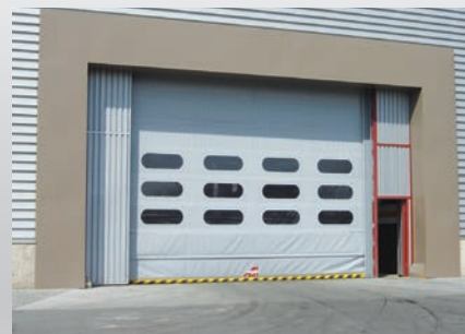
Puerta rápida en nave industrial.
