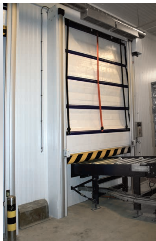
Instant-Pass® ISO en almacén de congelación con cinta de rodillos.
