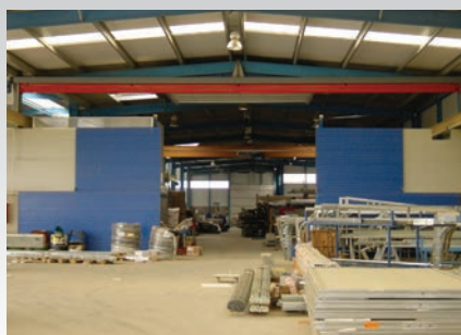
Puerta rápida puente grúa.
