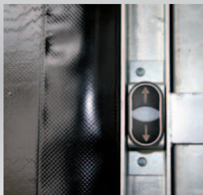
Detalle pulsador de ajuste faldón superior.
