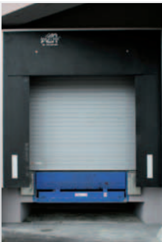
Muelle de carga con trampilla para plataforma de camiones.
