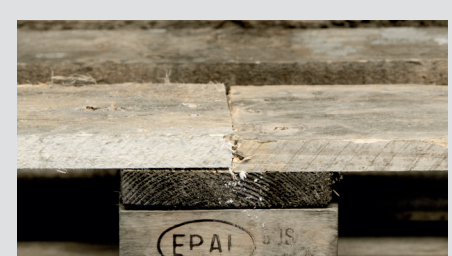
Reparación no conforme a las especificaciones.
