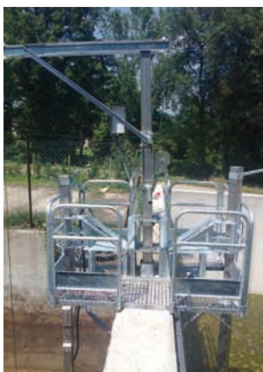
SOPORTE PARA AGITACIÓN DÚO Aprovechamos un solo agitador para dos depósitos juntos
