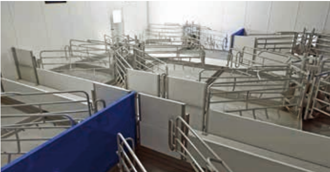
Sala de partos antes de poner las rejillas.
