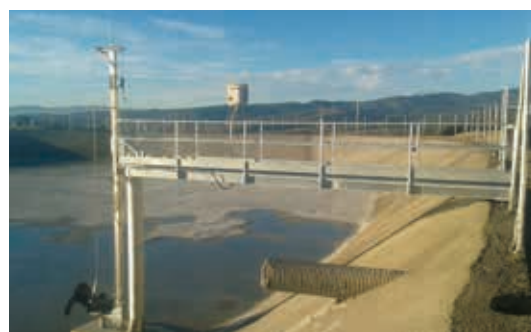
SOPORTE PARA BALSAS TALUD CON APOYO INTERIOR Para balsas de nueva construcción, con talud de cemento o PVC
