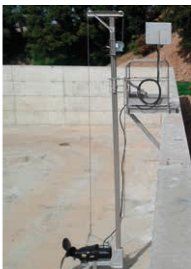
SOPORTE PARA DEPÓSITOS ABIERTOS DE PARED VERTICAL Para depósito abierto de hormigón
