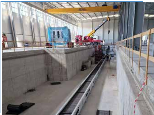
Sistema di trasporto sfridi posto sottostante una linea di presse
