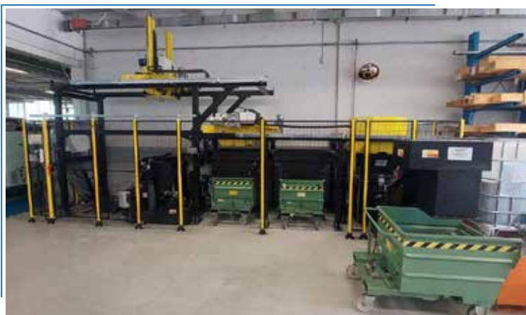
Tre stazioni di scarico, centrifugazione e triturazione finale
