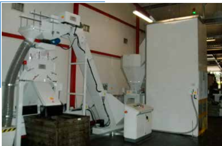
Impianto di triturazione e centrifugazione con elevatore ribaltatore per trucioli di acciaio
