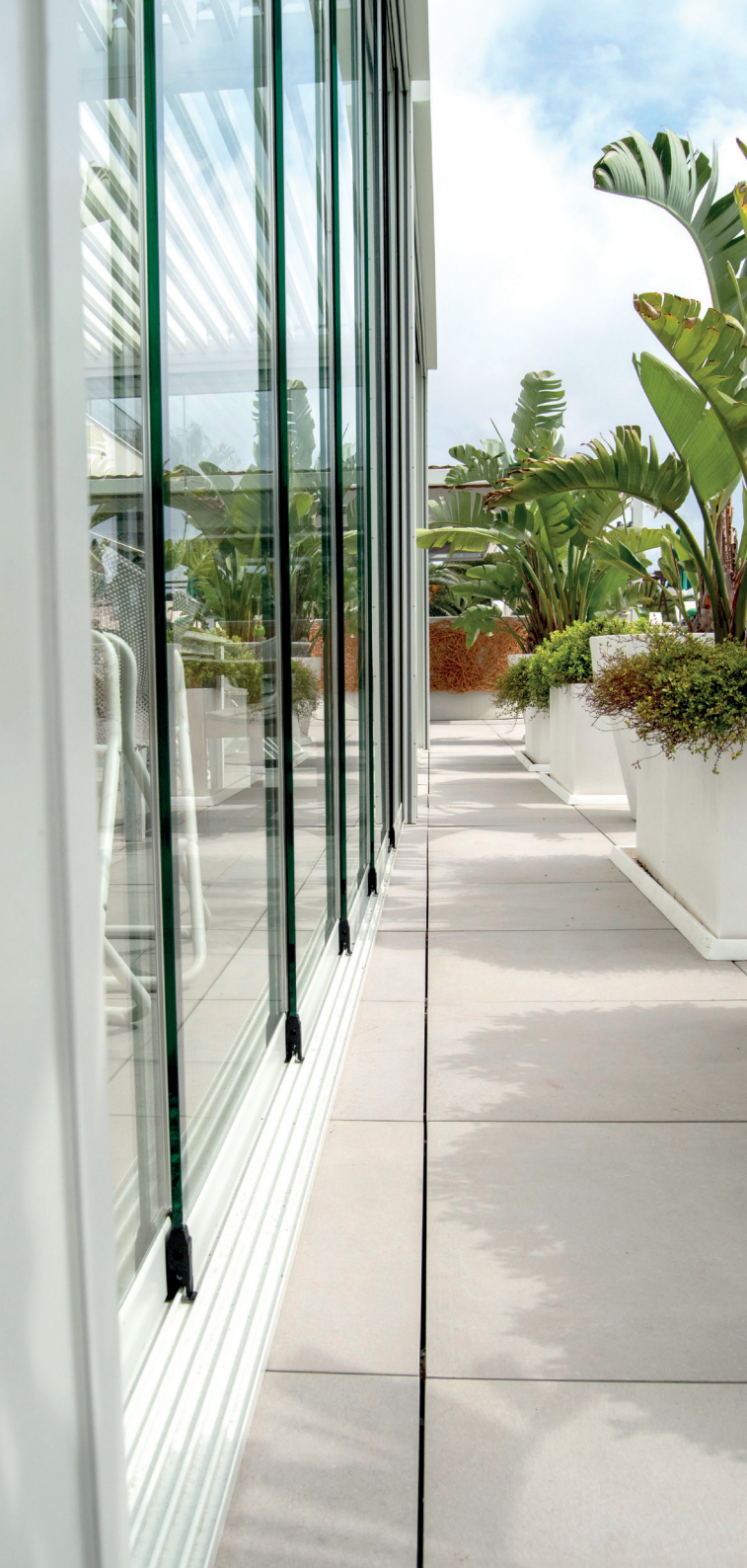
Perfil inferior sobrepuesto con salidas de agua oculta con deflectores. Overlapping bottom profile with concealed water outlets with baffles.
