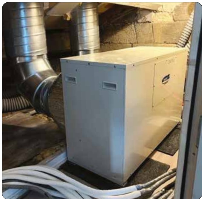
Ejemplo de instalación de un Elfo3-24 en ático con colector R-552230 y salida a techo.
