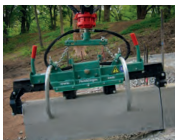
Ajustes de inclinación Colocación de bordillos en suelo con pendiente
