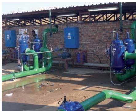
Irrigation protection for drip lines Protección sistema de riego
