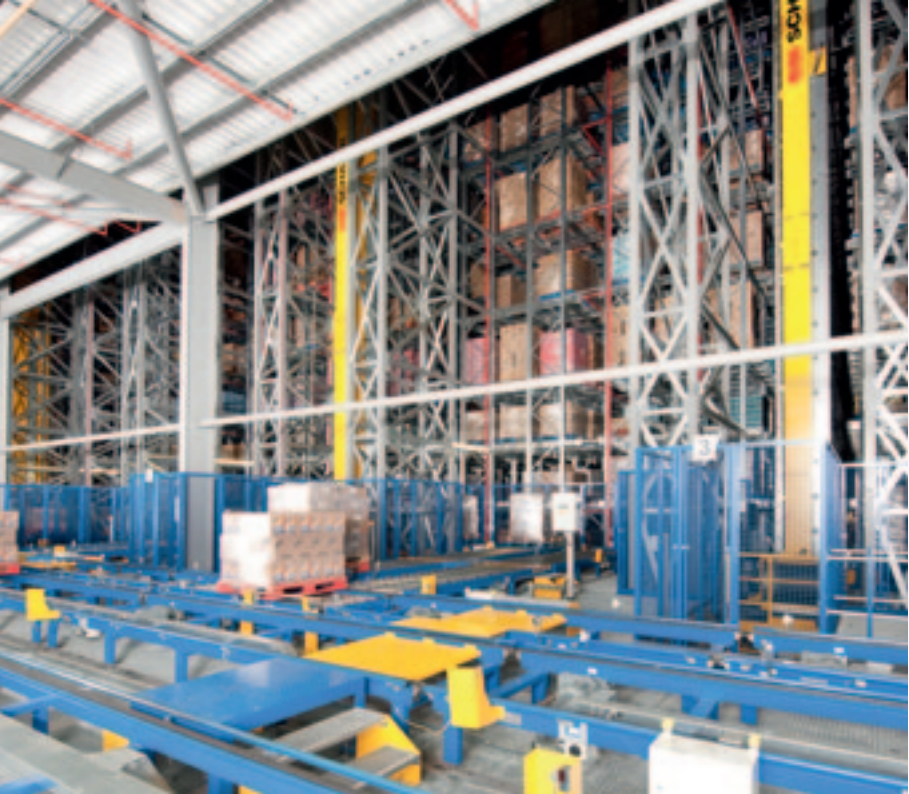
Almacén de gran altura con 11 transelevadores y 46.000 ubicaciones de almacenamiento
