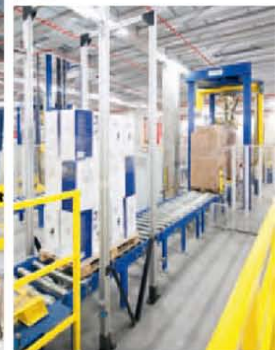
Captura, registro IT, control de galíbo y de peso así como aseguramiento del transporte de los palets
