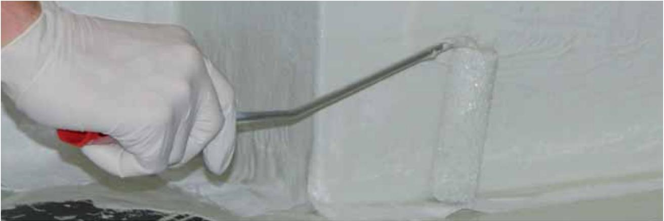
Las membranas líquidas **Sikalastic®** se pueden emplear con mallas de refuerzo de fibra de vidrio alrededor de todo tipo de detalles, como por ejemplo, petos, patas de equipo o alrededor de pasatubos, para realizar la impermeabilización continua.
