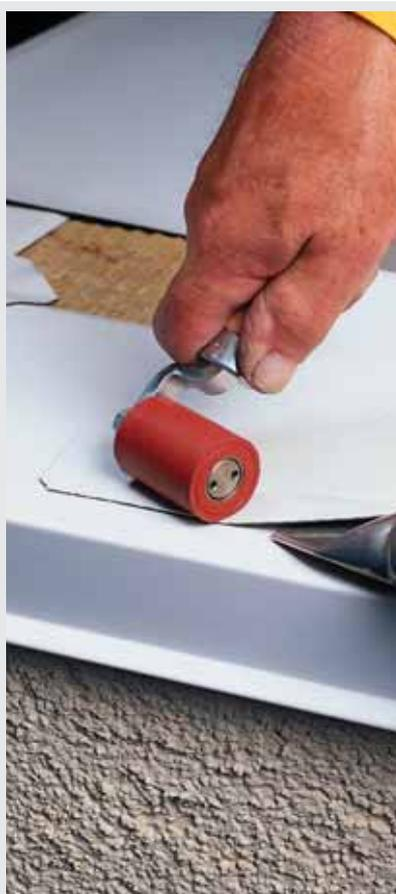
Los perfiles colaminados consisten en un perfil metálico galvanizado laminado por la cara exterior con la membrana **Sikaplan**® o **Sarnafil**®. El laminado tiene las mismas propiedades y compatibilidad que las membranas de cubierta. A los perfiles colaminados se puede soldar fácilmente a la membrana impermeabilizante para su instalación.
