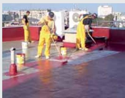
Las membranas líquidas para cubiertas monocomponentes se aplican principalmente con rodillo y con brocha (las brochas se utilizan sólo para los detalles).
