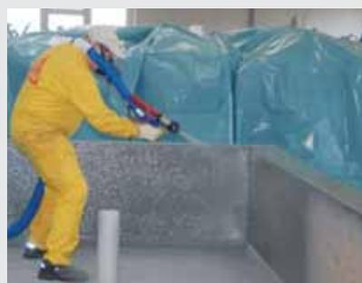
Las membranas de PU bicomponentes se aplican normalmente empleando una máquina de proyección de dos componentes en caliente.
