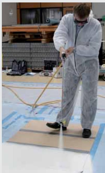
Además de con rodillo, las membranas líquidas de PU monocomponentes también se pueden aplicar con equipos de proyección airless. Este método se emplea en el sistema **SikaRoof® MTC 8** y para las capas de sellado de los demás sistemas **SikaRoof® MTC**. Se deben aplicar al menos dos capas por proyección para asegurar el espesor adecuado.
