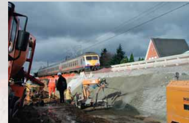
Estabilización de taludes
