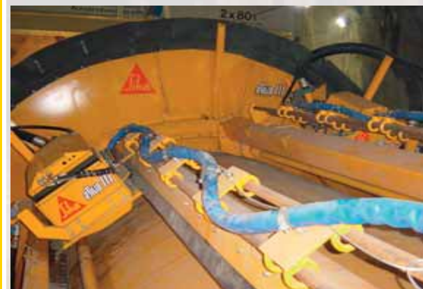
Sostenimiento con hormigón proyectado en TBM
