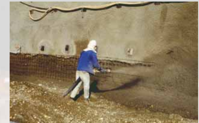
Estabilización de excavaciones
