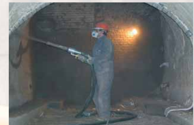
Reparación de túneles
