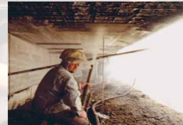
Reparación de puentes
