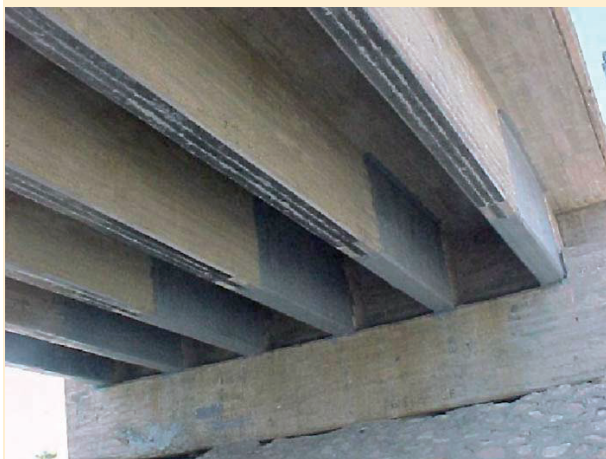
Detalle de encuentro de vigas reforzadas con dintel.
