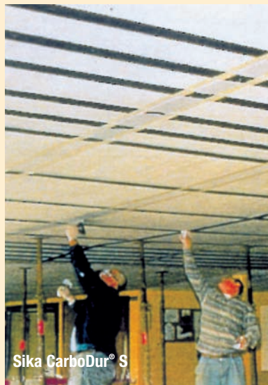
Losa de hormigón reforzada
