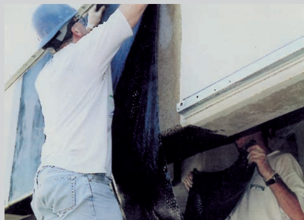
Aplicación del Sistema SikaWrap® en el refuerzo a cortante de una viga
