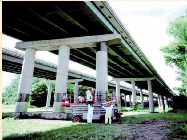
Refuerzo para cargas atómicas.
