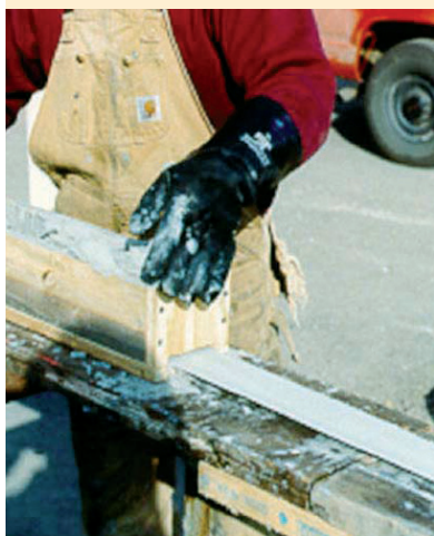
Aplicación de resina sobre el laminado (1-2 mm)
