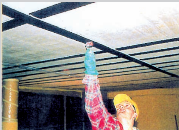
Refuerzo de hormigón armado con laminados Sika Carbodur®
