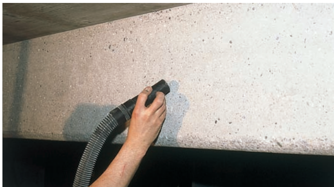
Preparación del Soporte de Hormigón
