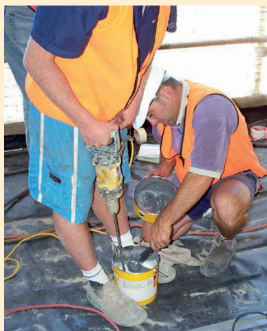
Mezclado de los dos componentes la resina con batidora de bajas revoluciones hasta que el color sea uniforme.
