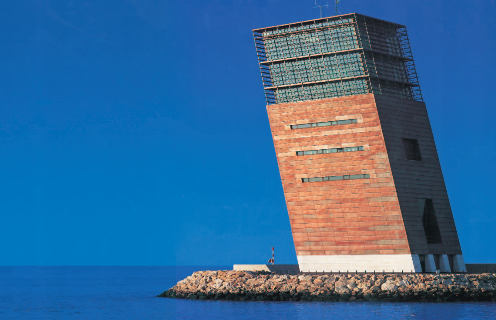
Torre de control del puerto de Lisboa
