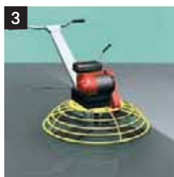
3 Alisado de la superficie p. ej. con un helicóptero
