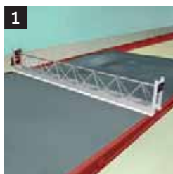
1 Levantar la superficie p.e. por medio de una regla vibrante
