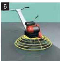
5 Regularización final p.e. con un helicóptero
