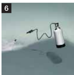
6 Tratamiento de curado Pulverizar un producto de curado
