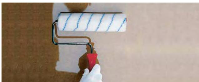
Aplicación de la imprimación con un rodillo de pelo corto.
