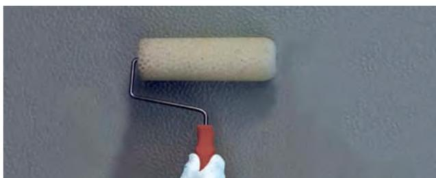
Aplicación de **Sikafloor®-264 + Extender T** para un revestimiento de alto espesor con un rodillo texturado.
