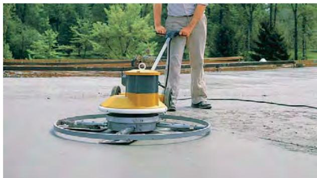
Helicóptero con un control de velocidad variable para el control del acabado con llana del hormigón y de pavimentos de resina.
