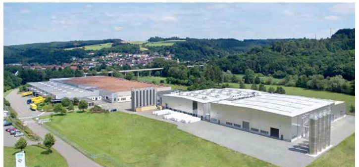
BITO Lauterecken - Planta de contenedores de plástico
