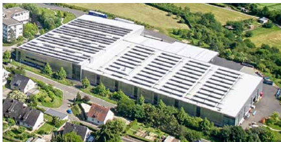
BITO Meisenheim – Paneles fotovoltaicos en la cubierta de la planta
