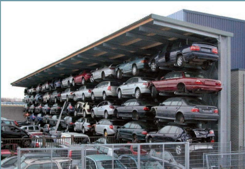
50 vehículos almacenados en resistentes estanterías cantilever con techo. Alta densidad de almacenamiento sobre poca superficie. Almacenamiento sencillo para el acceso rápido a todos los modelos.
