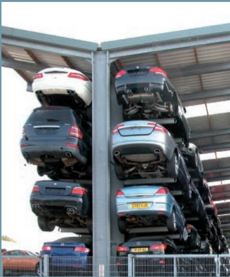
Si se desea, se puede techar cada lineal de estantería total o parcialmente. Para ello se tiene en cuenta la estática de las cargas locales de nieve y viento en el cálculo de los perfiles.
