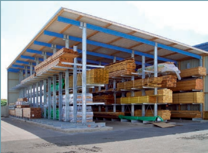
Nave autoportante cantiléver parcialmente cerrada con estanterías galvanizadas. Techo y pared de chapa trapezoidal de acero. Anexo armónico en una nave existente
