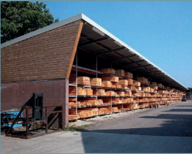
Nave de autoportante de paletas cerrada por tres lados para el almacenamiento de madera con diferentes surtidos y medidas de profundidad. Saliente de techo grande.
