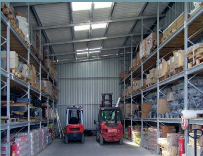
Nave autoportante de paletas para un comerciante de material de construcción. Completamente con techo y pared de chapa trapezoidal de acero. Incluida puerta corredera y claraboyas de iluminación. Protección adicional de los marcos de estante contra las fuerzas de choque.
