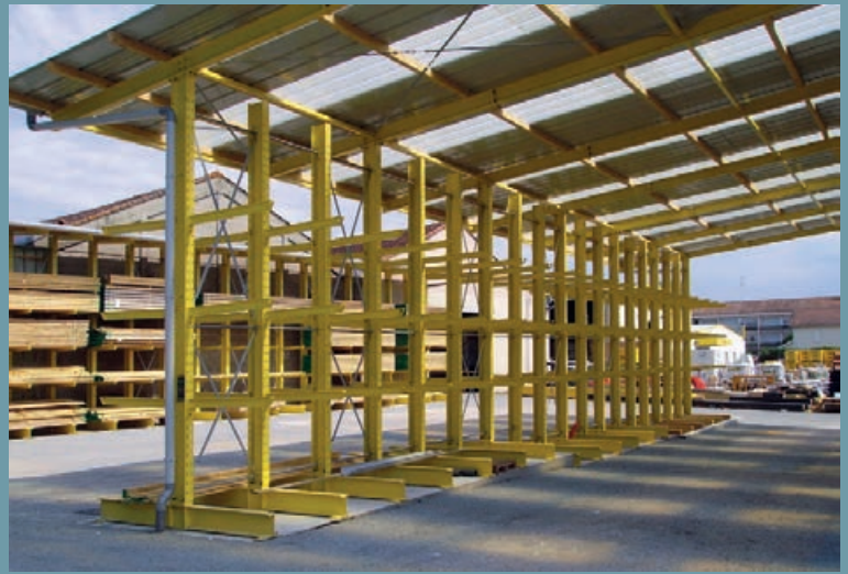
Nave autoportante cantiléver abierta para el comercio de madera. Completamente con cubierta de tejado de chapa trapezoidal, incluidas bandas de iluminación, canalón y tubo bajante. Zapatas de cemento con compensación de altura.
