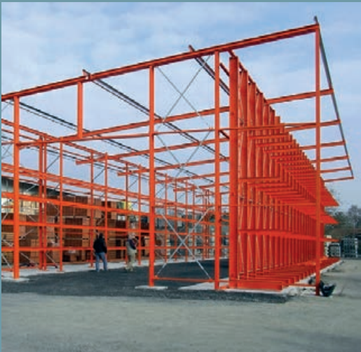
Construcción autoportante, consiste de estanterías cantiléver y de paletas. Subconstrucción, incluso frontón, un poco antes del revestimiento. Calcular estáticamente las cimentaciones de candellero y las zapatas cimiento.
