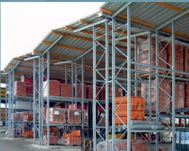
Nave abierta autoportante de paletas para el almacenamiento de materiales de construcción. Regla de ambos lados, completamente galvanizado, instalado sobre zapatas de cemento.
