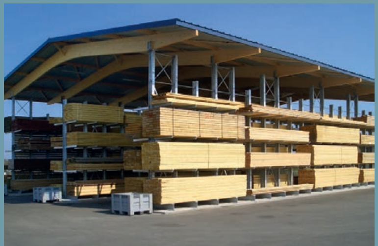
Nave autoportante cantiléver abierta con estanterías cantiléver galvanizadas de ambos lados tres veces. Construcción moderna del tejado pendiente con 10 m de envergadura
