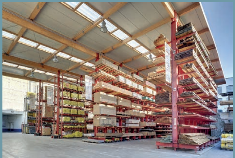
Nave autoportante abierta. Combinación de estantería cantiléver y de paletas como construcción portante para el techo. Iluminado, con gran envergadura para el paso de camiones
