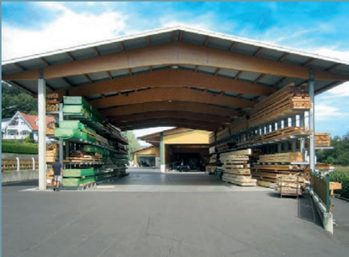
Nave autoportante abierta con estanterías cantiléver galvanizadas de ambos lados. Construcción moderna con tejado de pendiente con cubierta de chapa trapezoidal. Placa base grande
