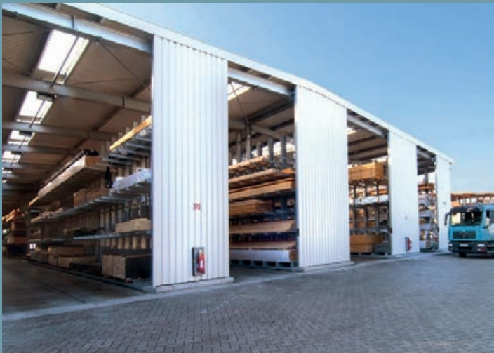
Almacén de madera con revestimiento de pared y techo. Estanterías cantiléver completamente galvanizados como almacén de pasillo estrecho. Bandas de iluminación en cada pasillo.
