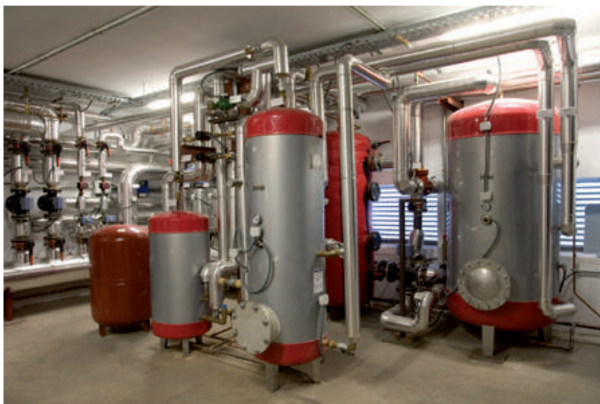
Depósitos de la instalación Energía Solar Térmica del Edificio Ferrolí.
