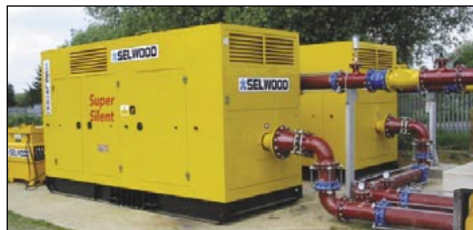
Purgado y cebado de tubería de trasiego (RU)
