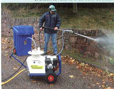
Limpieza chorro arena
